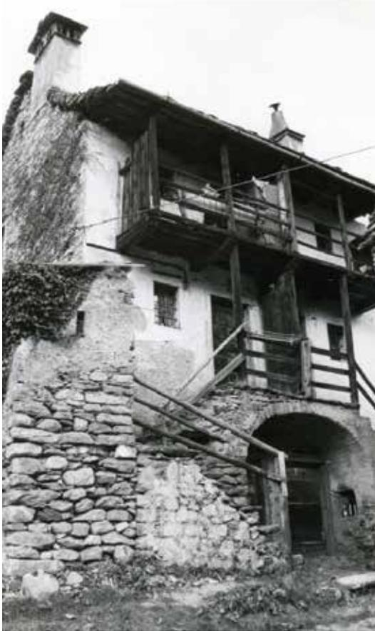
**Fig. 4: Casa d'abitazione con ballatoio sul lato di gronda Torriggia, Val Divedro.**
